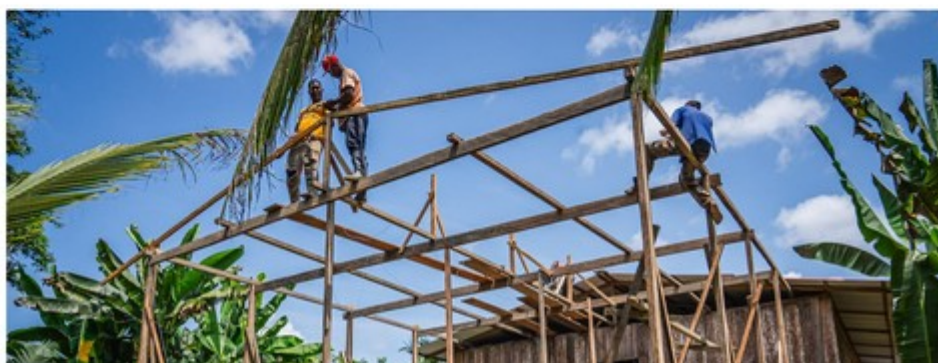
Construcción de Refugio Humanitario en Raposo, Buenaventura (Colombia) LUIS MANGRANÉ CUEVAS
